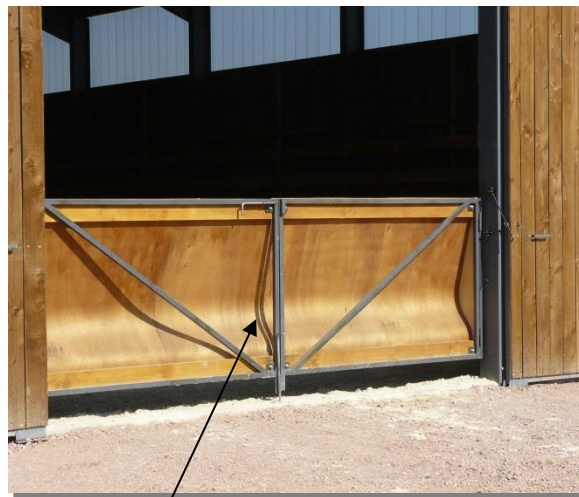
Portail : jonction des 2 portes par une coupe de biais
